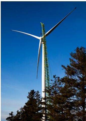
Siemens 3.0 MW turbine
